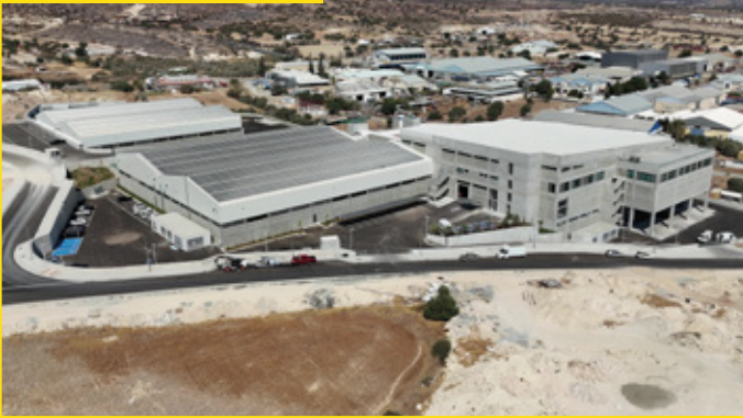
Εργοστάσιο Εμφιάλωσης - Λεμεσός
