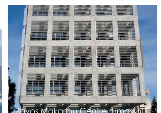
Zavos Makariou Centre, Limassol
